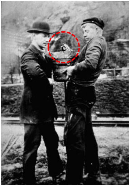
Figur 1. Manuell viktsondering där förmannen (t.v.) håller i stångtoppen för att notera vibrationer vid penetration genom friktionsjord.
