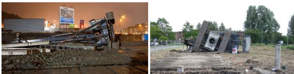
Figur 1. Foton av Skanskas pålkranar vid olyckorna 2011 respektive 2012.
