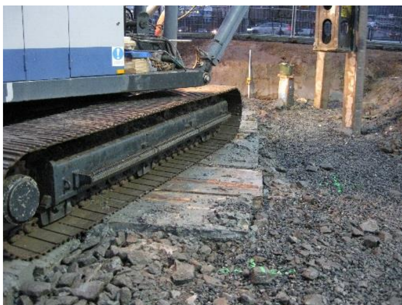
Figur 7. Exempel på en pålkran som inte "håller sig på (stock)mattan" – åtminstone inte så som föreskrivits i Figur 5.
