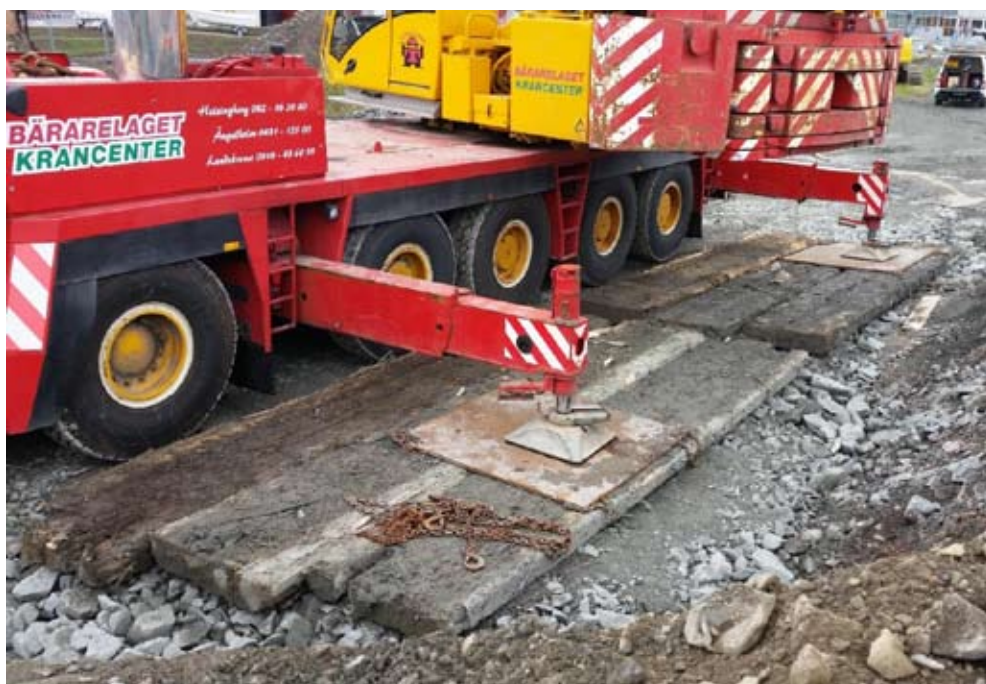
Figur 6. Exempel på en kranuppställning där poängen med lastspredande stockmattor delvis gått förlorad (Foto: Michael Sabbatini)
