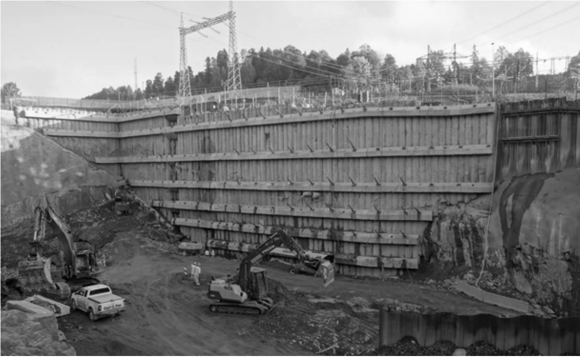
Figur 10. Bild på sekantväggen.
