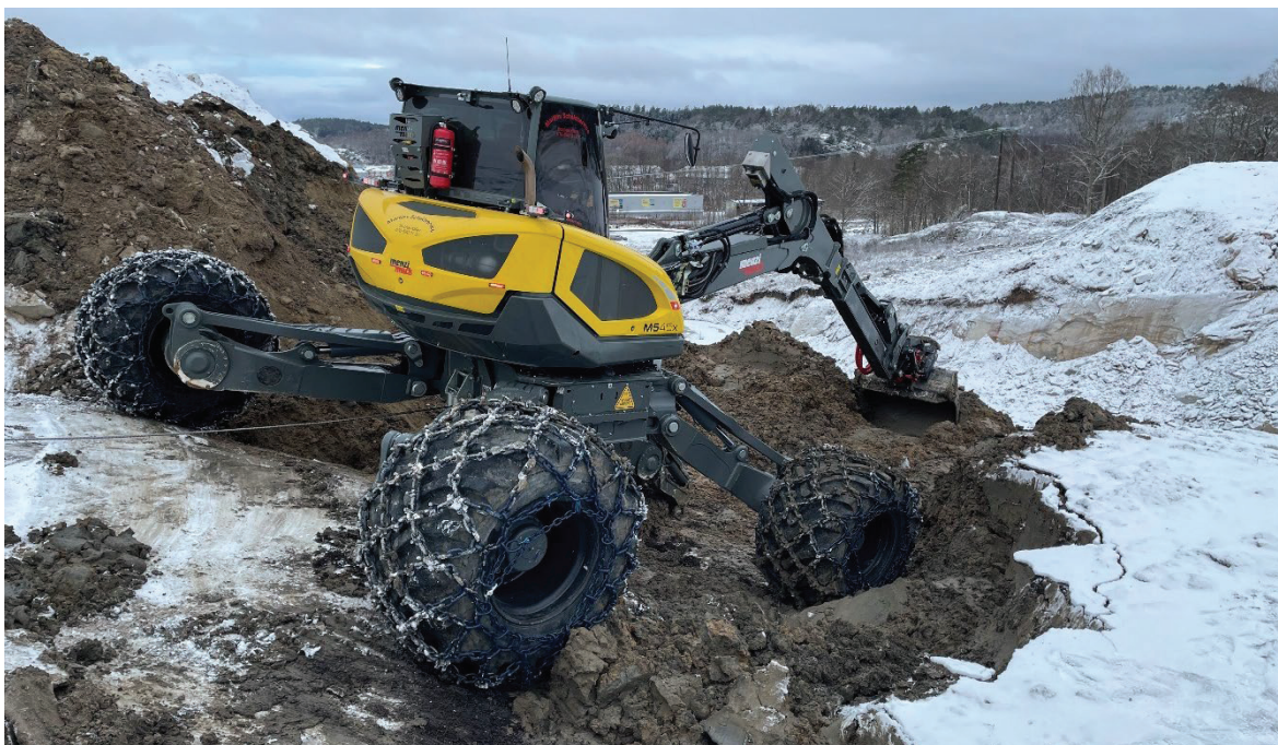
Figur 7 Foto på "spindelgrävare" som användes för att ta ner lösa jordmassor på sluttande berg (Foto: Peab)
