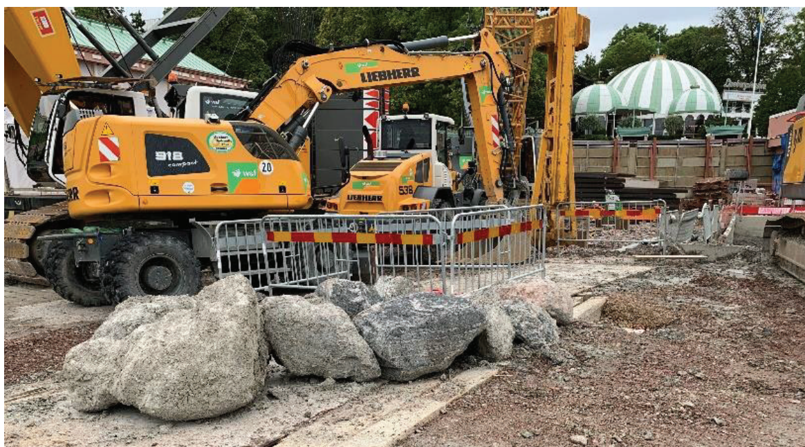
Figur 6 Block som tagits upp ur schakten för slitsmuren.
