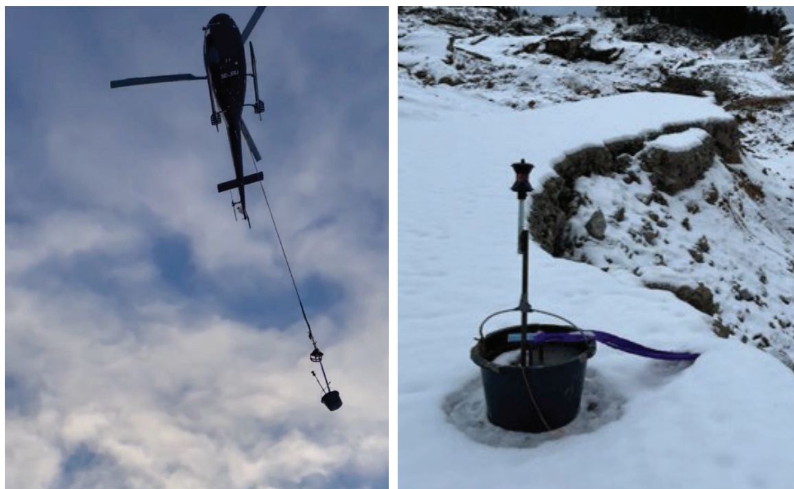
Figur 8 Installation av mätpunkter med helikopter, samt utförande av fundament för mätprisma (Foto: Peab)
