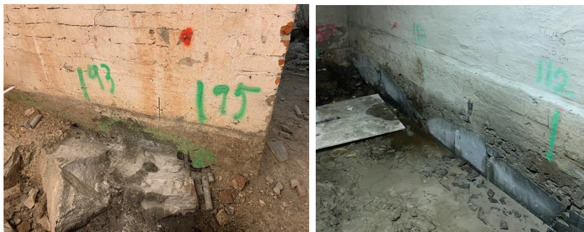
Figur 3 – Till vänster visas hur kallmuraren i BY31 stack ut vilket var ett problem för maskinen. Till höger efter kapning med diamantsåg.
