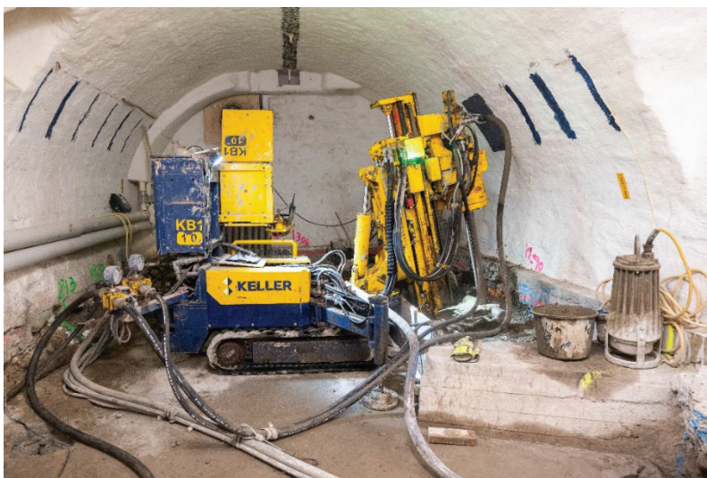
Figur 3-2: Maskin för jetinjektering under Postmuseums källarvalv
