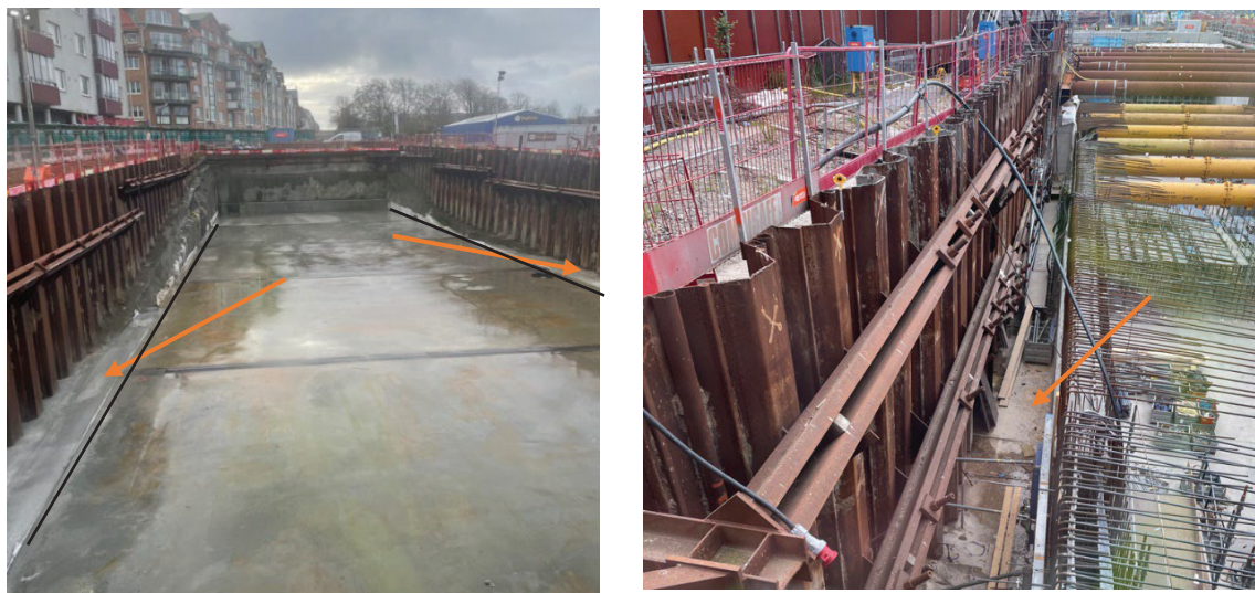
Figur 5: Bilder som visar gjutningar och s.k. ”negativ betong”. Till väster kan den negativa betongen ses mellan konstruktionsbetongen och spanten/berget. Till höger kan den s.k. ”negativa betongen” mellan armeringen och spantplankan.
