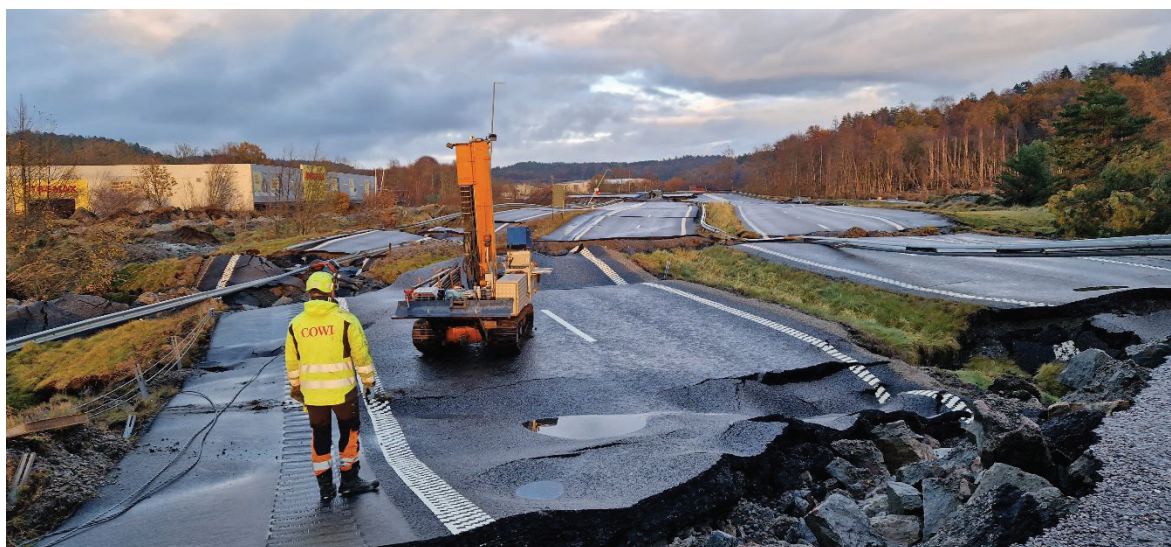
Figur 3 Foto Geotekniska undersökningar i skredområde (COWI)
