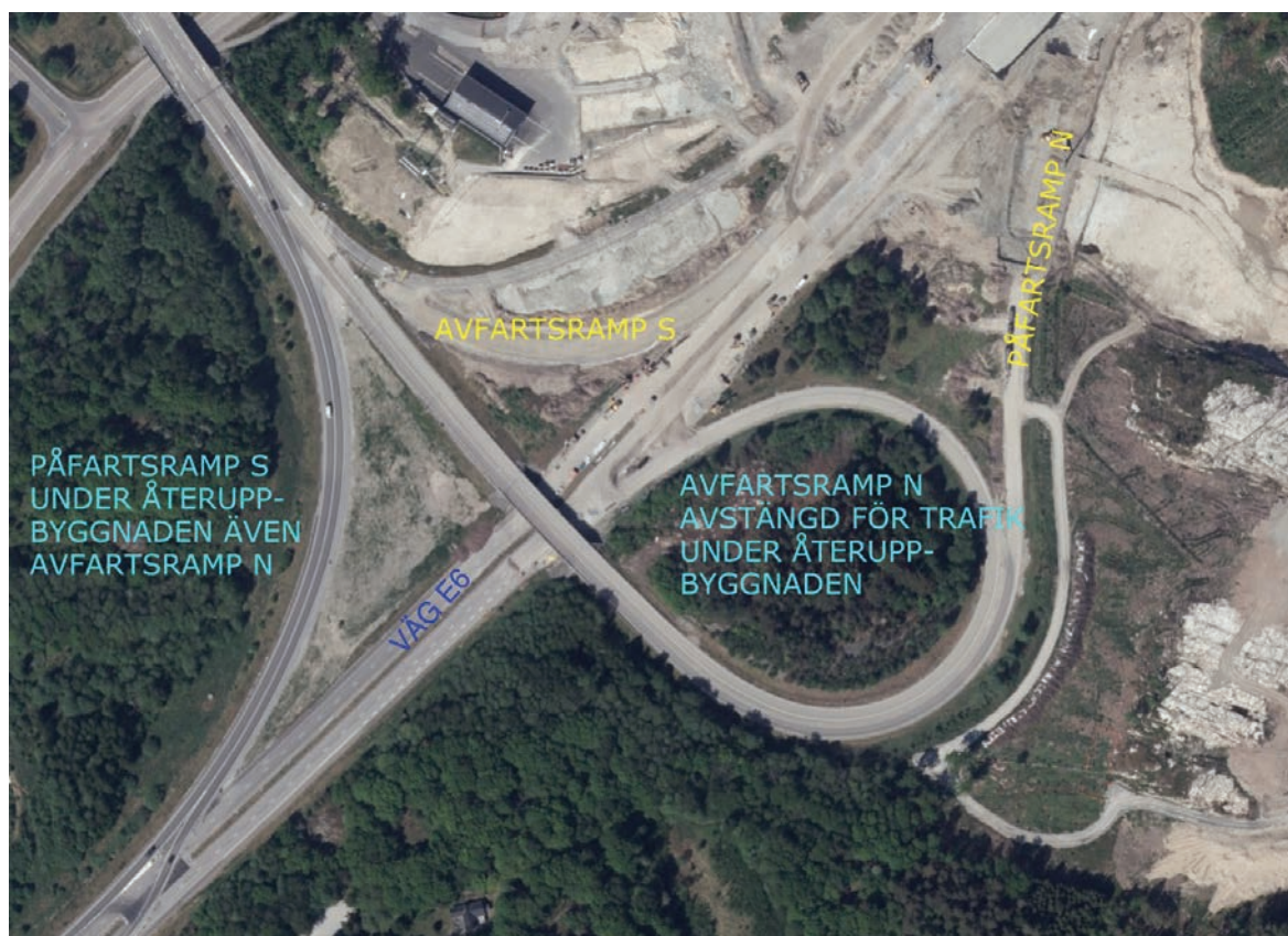
Figur 2 Trafikplats 91, Stenungsunds motet med avfartsramp S som under återuppbyggnaden byggdes om för att även utgöra avfartsramp för norrgående trafik på väg E6 (Min Karta, Lantmäteriet).
