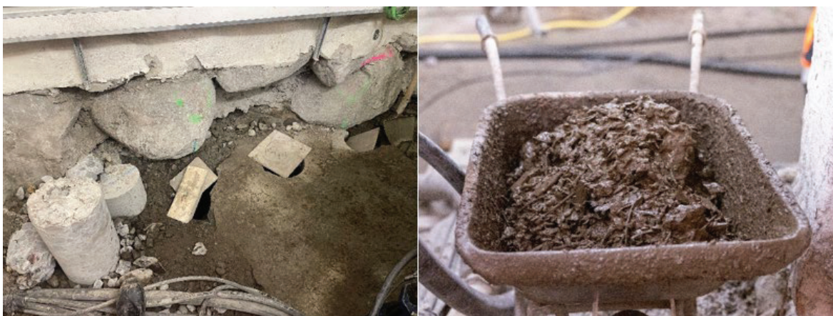
Figur 3-2: Håltagning 300 mm samt exempel på icke-pumpbart returflöde (träflis) som manuellt hanterades med skyffel och skottkärra
