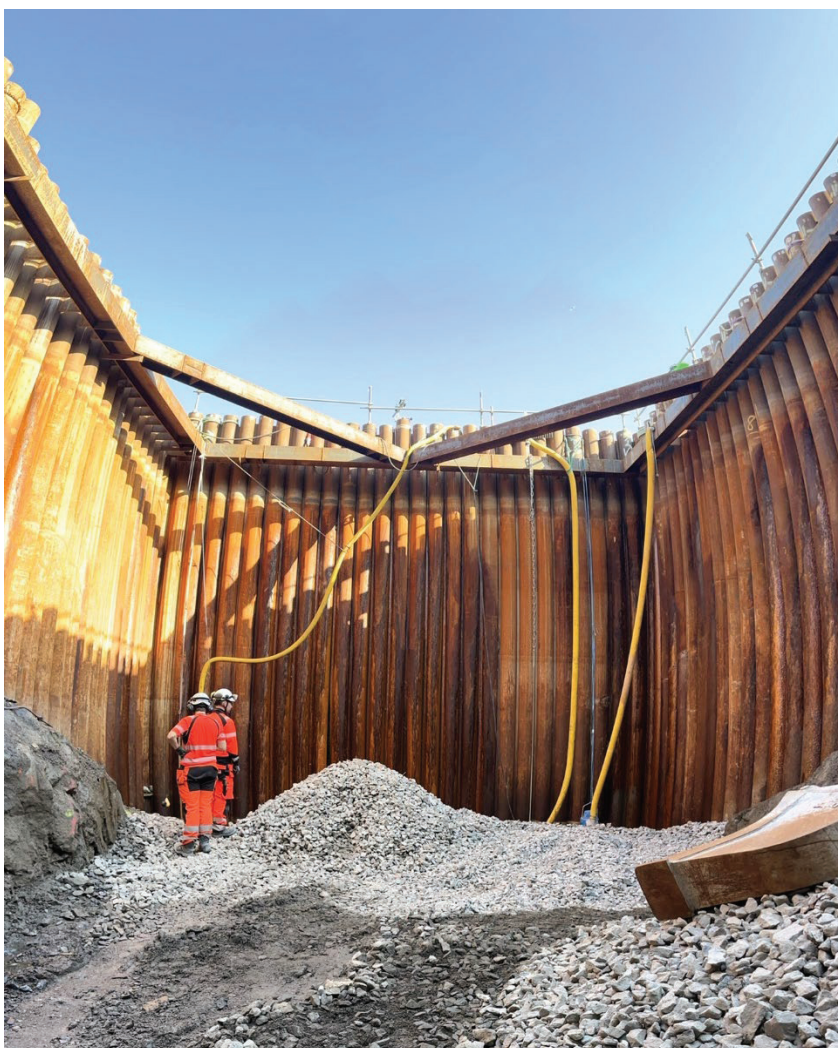
Figur 7: Slutgiltigt resultat för stödkonstruktionen
