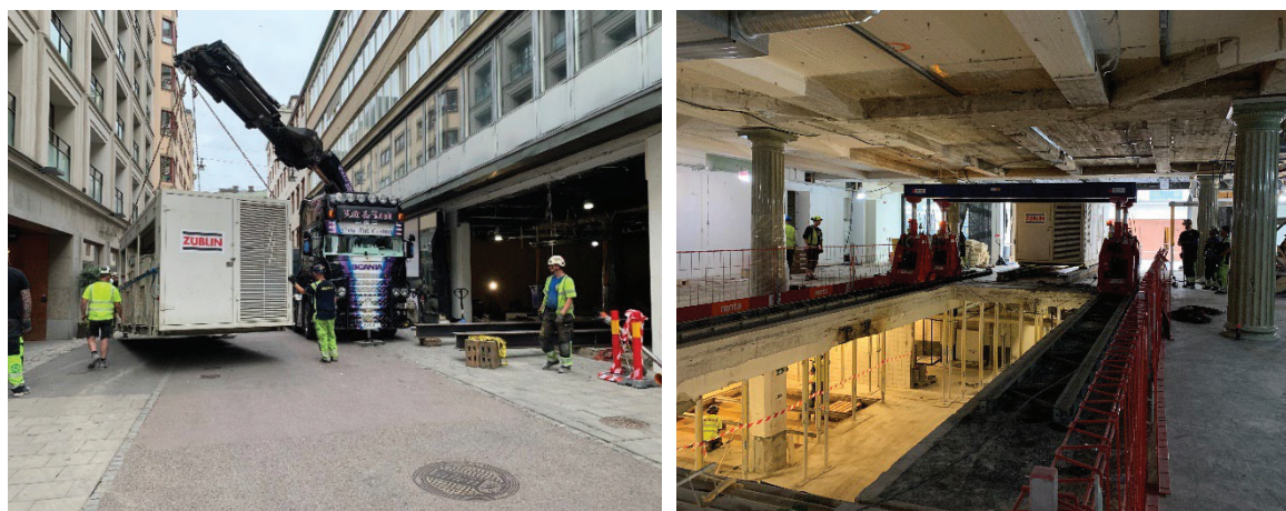
Figur 5 – Moment när fabriken placeras i läge för lansering in i byggnaden där öppningen i golv utfördes för att ställa fabriken i slutligt läge på källargolv.
