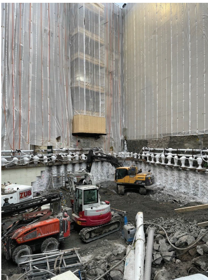
Figur 7 – I bilden pågår schakt, fräsning av fryst jord innanför spont och isolering i Område 1. Ovanför spont syns matarledningarna och inkopplingen till frysrören.
