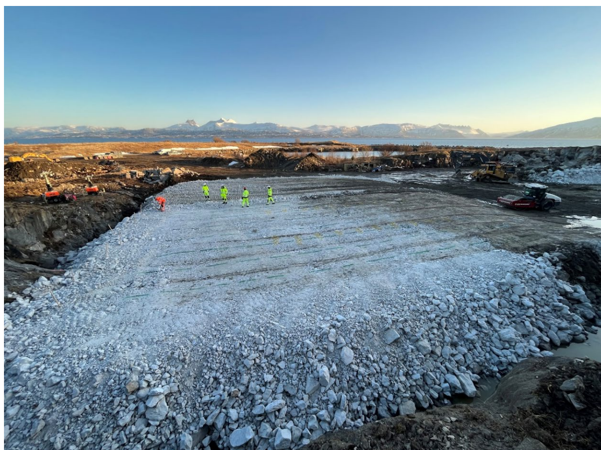
Figur 10 Provbänk för packningsförsök.
