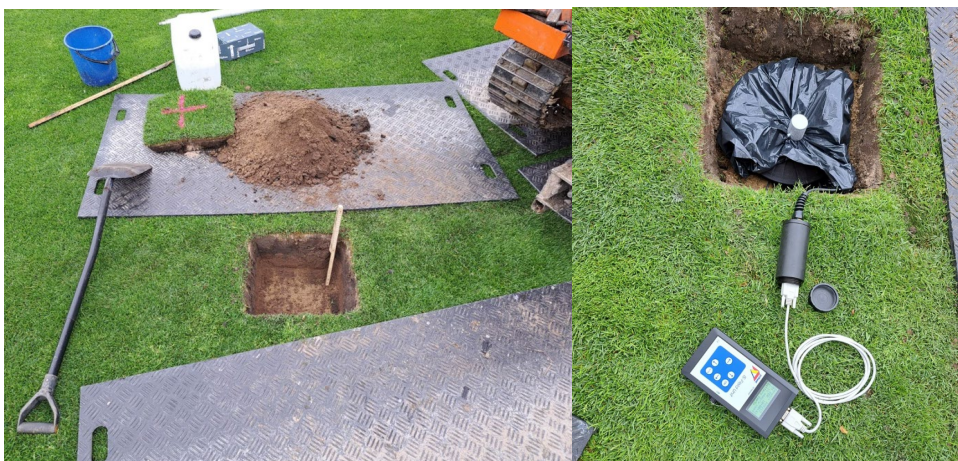
Figur 3. BAT-piezometrar installation i fältet
