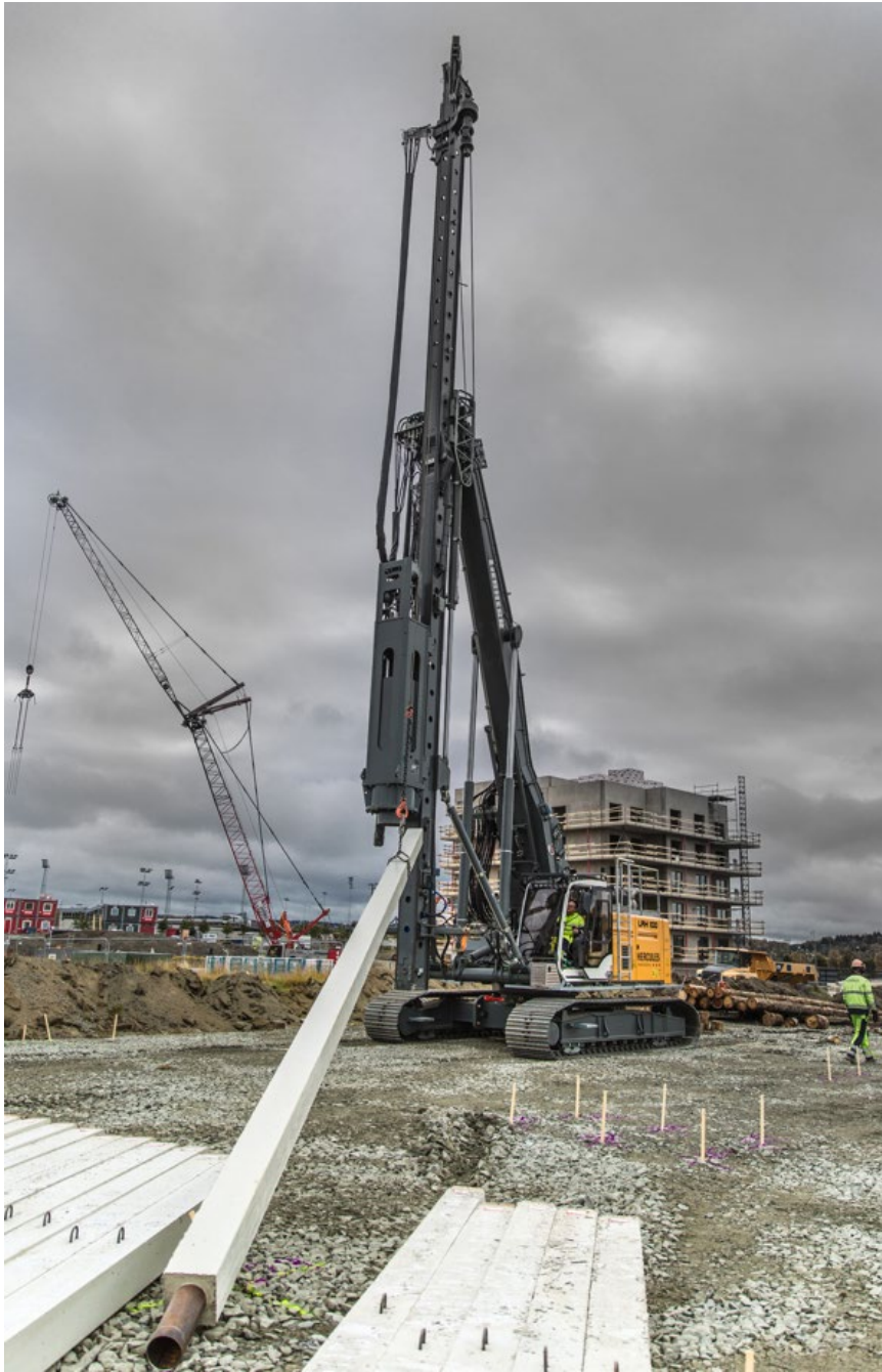
Figur 5. Vanligt förekommande pålrigg för betongpålar.
